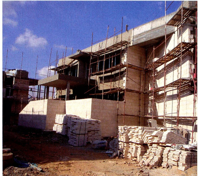
Die neue Schule in Jerusalem im Rohbau.
