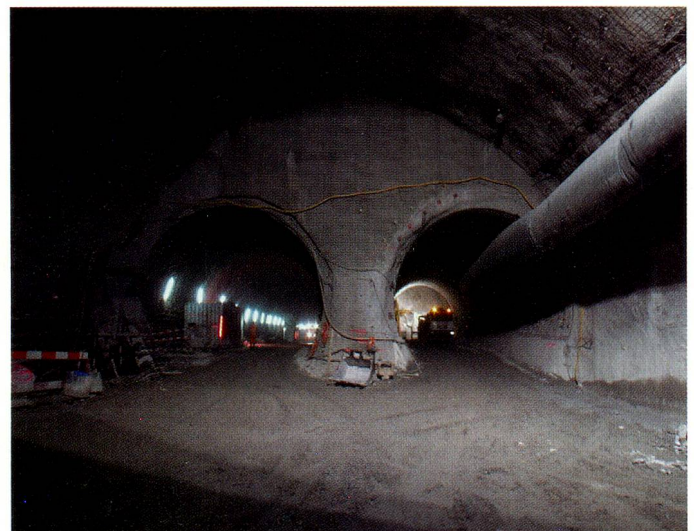
Mit 57 Kilometern ist der neue Basistunnel der längste Eisenbahntunnel der Welt.
