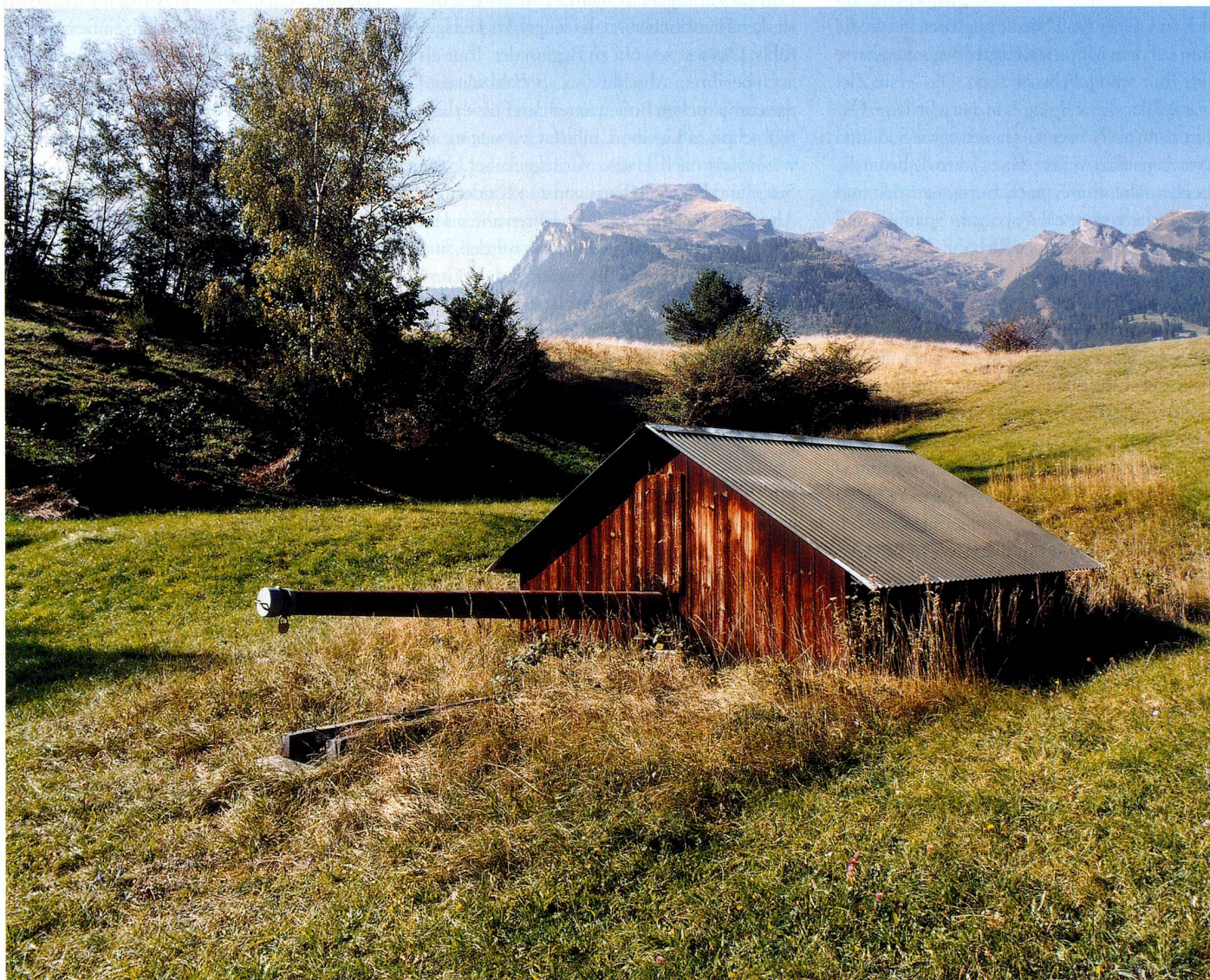
Hütte, 1939–43, Panzerturm der Festung Magletsch, Oberschan SG: Der Panzerturm ist umhüllt mit einer Bretterschalung und einem Wellblechdach. Das Panzerrohr ist unverkleidet und mit einem Mündungsdeckel geschlossen.
