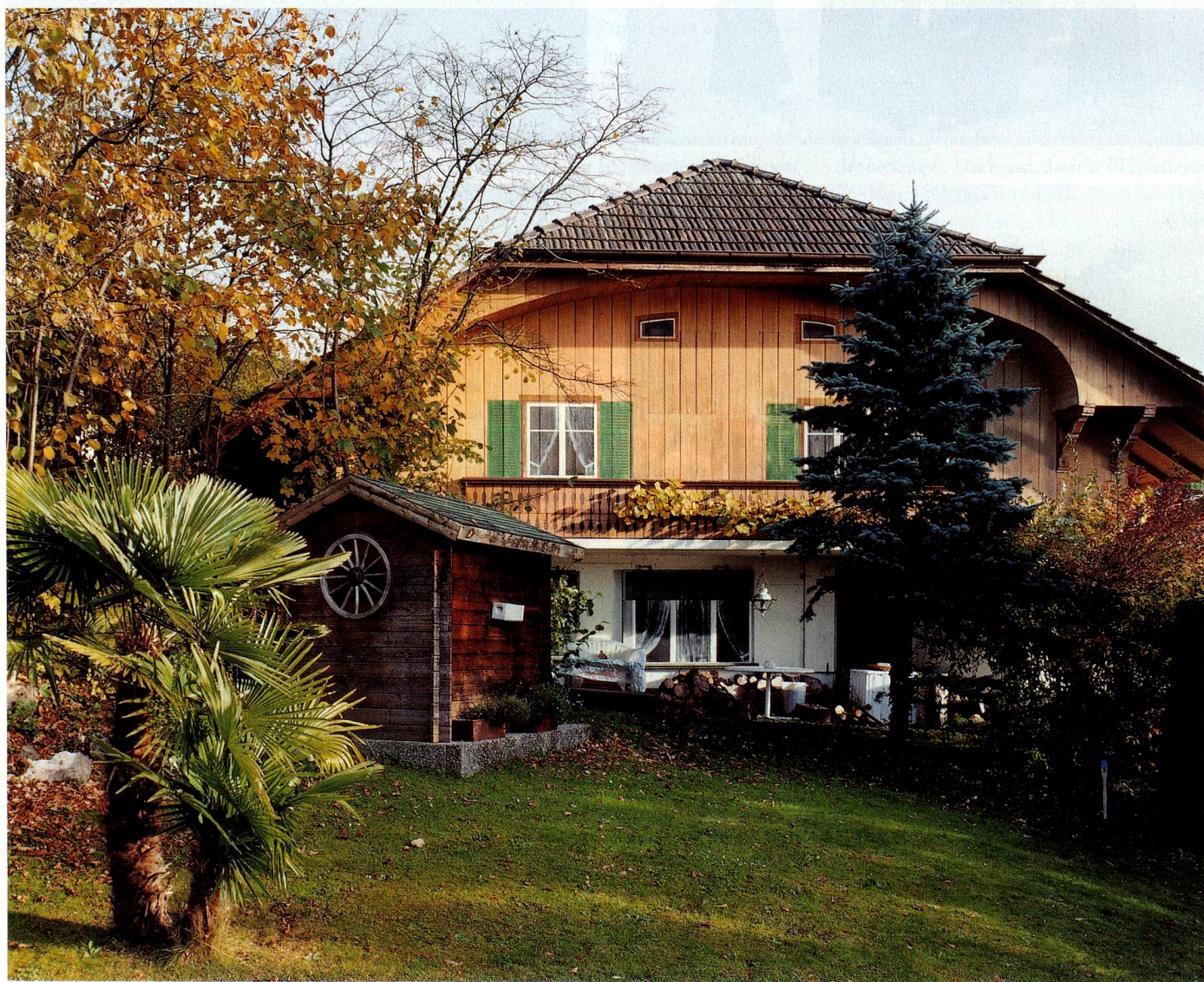
Chalet, 1941, Infanteriebunker, Hilterfingen BE: Betonbau mit ziegelbedecktem Krüppelwalmdach und gewölbter Dachuntersicht. Fenster, Läden und Balkonbrüstung sind auf die Holzschalung aufgemalt. Unter dem Rücksprung befindet sich der Scharntendeckel, der als ein Fenster mit halbgeöffnetem Rollladen erscheint.
