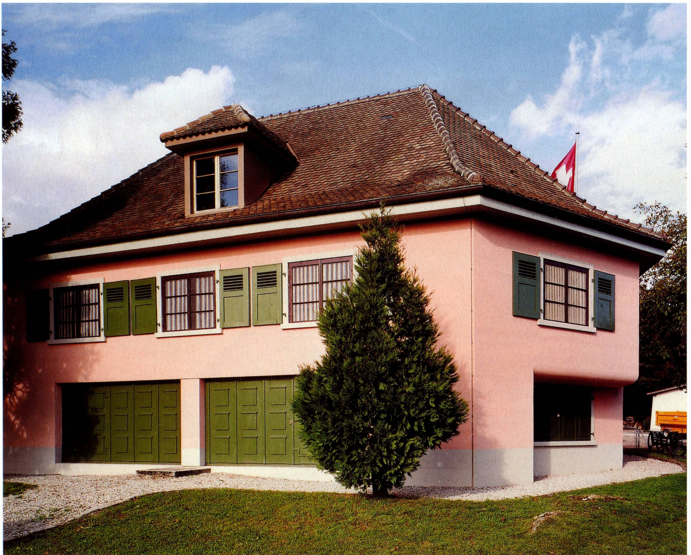
Villa, 1940, Infanteriebunker, Gland VD: Massivbau mit Walmdach und Ziegeleindeckung und Lukarne. Hinter den aufgesetzten Fenstern sind, direkt auf den Beton, Vorhänge aufgemalt. Der Bunker wird heute als Museum genutzt.
