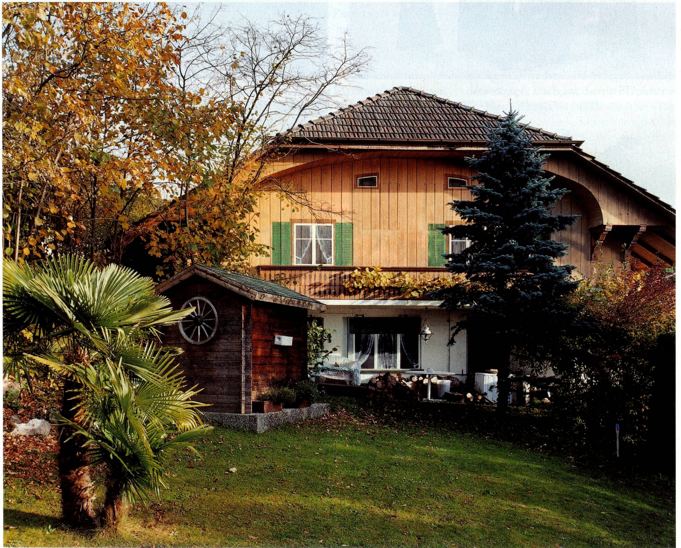
Chalet, 1941, Infanteriebunker, Hilterfingen BE: Betonbau mit ziegelbedecktem Krüppelwalmdach und gewölbter Dachuntersicht. Fenster, Läden und Balkonbrüstung sind auf die Holzschalung aufgemalt. Unter dem Rücksprung befindet sich der Schartendeckel, der als ein Fenster mit halbgeöffnetem Rollladen erscheint.
