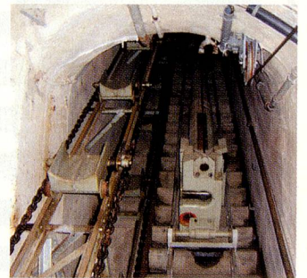
Munitionsaufzug zu einem der Geschütztürme.
