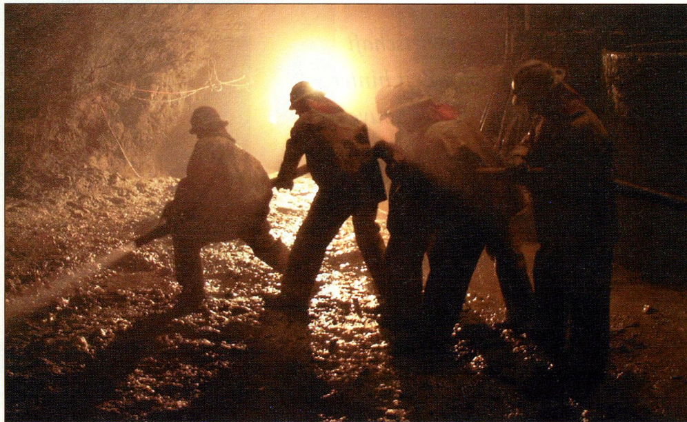
Teamwork ist das A und O im Untertagbau.
