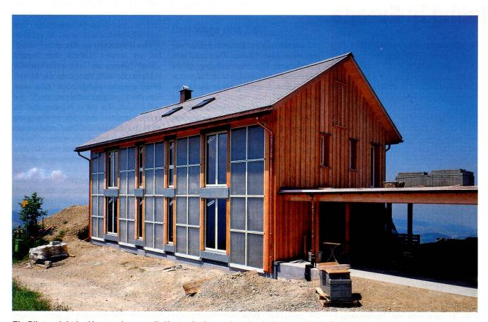
Ein Pilotprojekt im Kanton Appenzell: Hauswände werden durch die neue Technik der transparenten Wärmedämmung zu Sonnenenergie-Lieferanten. (Foto: Oerlikon Journalisten)
