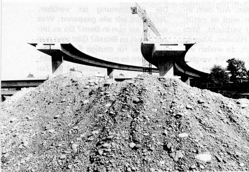
Gleiche Spiesse für Strasse und Schiene? Bild: Bau einer Autobahn in Basel.
