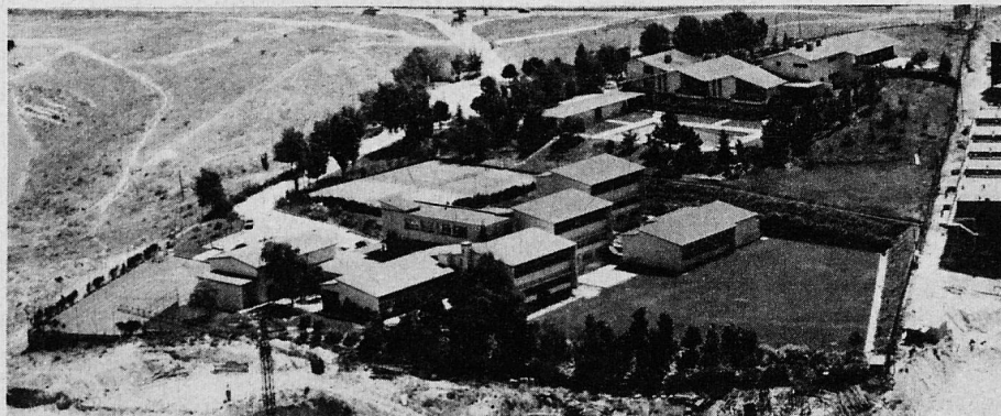
Vue d'ensemble des installations du Collège et de la Sociedad Suiza Helvetia
