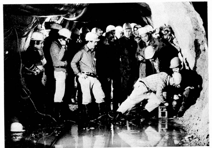
Der Gotthard-Tunnel nimmt Form an: hier die letzte Sprengung.
