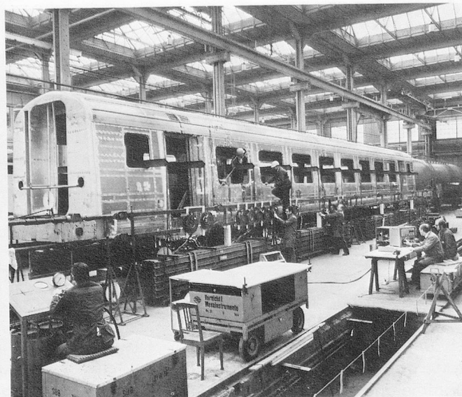
Construction d'un wagon CFF à Neuhausen (SIG).
