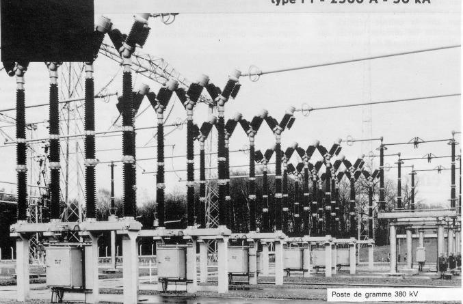
Ce même poste de Gramme est équipé de disjoncteurs 170 kV, type FS 2500 A - 40 kA Actuellement, plus de 1000 groupes tripolaires de la série F sont en service.
