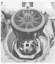
Mise en place d'un rotor d'alternateur. Het aanbrengen van een alternator-rotor.
