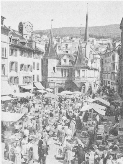
La place et la maison des Halles
