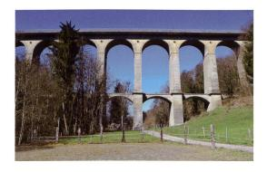
Abb. 44: Der 1853–1858 grösstenteils von Sträflingen erbaute, 53m hohe und 183 m lange Glâneviadukt nach Plänen von Richard La Nicca. Pfeiler aus lokal gebrochenem Molasse-Sandstein, Travertinbasen von der Tuffière. Blick von Westen (Photo: H.U. Feldmann).
