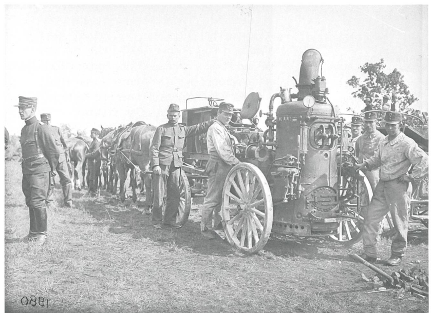
Abb. 69: Die Dampfwinde, mit der die Ballonpionier-Kompanie im Sommer 1913 den Ingenieur Gustav Kammerer als «Topograph im Ballon» über den Belpberg steuerte (Abb. 28–31). Aufnahme von Ingenieur Johann Ganz. Glasplattennegativ 12x9 cm (swisstopo, Bildsammlung, technische Aufnahme 1880, Inv. Nr. 000-392-367).
