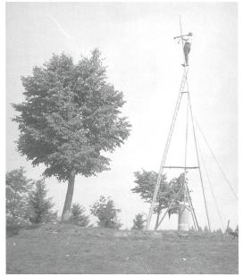
**Abb. 62:** Einfaches Leitergerüst zur Rekognoszierung auf dem Triangulationspunkt 2. Ordnung Homberg nördlich von Reinach AG, 1909. Ingenieur Werner Lang (1885-1945) gelingt es, 18 m über dem Boden die Sicht nach der Gisliflue südlich von Thalheim sicherzustellen, Für die spätere Messung musste somit ein Beobachtungsturm gebaut werden. Glasplattennegativ 9 x 12 cm (swisstopo, Bildsammlung, technische Aufnahme 53, Inv. Nr. 000-389-695).
