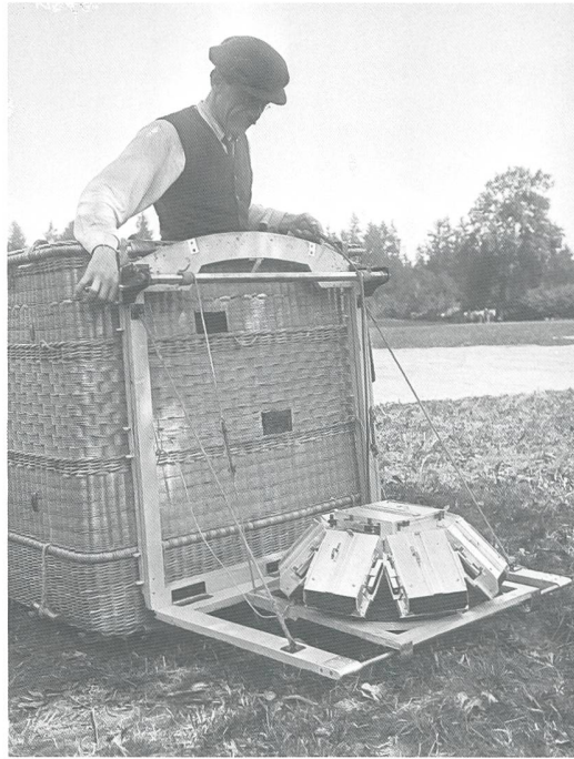
Abb. 29: Ingenieur Gustav Kammerer im Ballon, an dessen Aussenseite der «Photo-Perspektograph» hängt, ein Kamerasystem mit einer zentralen und sieben radial angeordneten Kameras, das polygonal begrenzte Abbildungen erzeugt (vgl. Abb. 31). Glasplattennegativ, 12 x 9 cm (swisstopo, Bildsammlung, Technische Aufnahme 1878).
