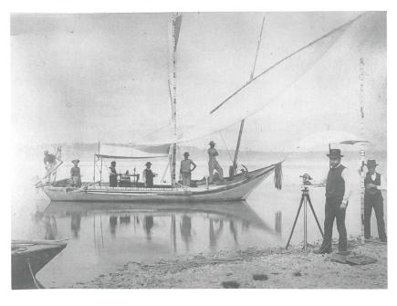
Abb. 66: Die Kartierung des Unbekannten: Schiff «Sondeur» 1888/89 auf dem Genfersee mit dem Seetiefenlotungsapparat der L+T, der von Ingenieur Jakob Hörnlimann (1846–1933) bedient wird. Paul Etier (1863–1919), der von 1902 bis 1919 als Waadtländer Staatsrat wirkte, vermisst als junger Topograph mit dem Messtisch vom Ufer aus die Position des Schiffes im Moment der Sondierung. Glasplattennegativ 12x9 cm (swisstopo, Bildsammlung, technische Aufnahme 1063, Inv. Nr. 000-390-718).
