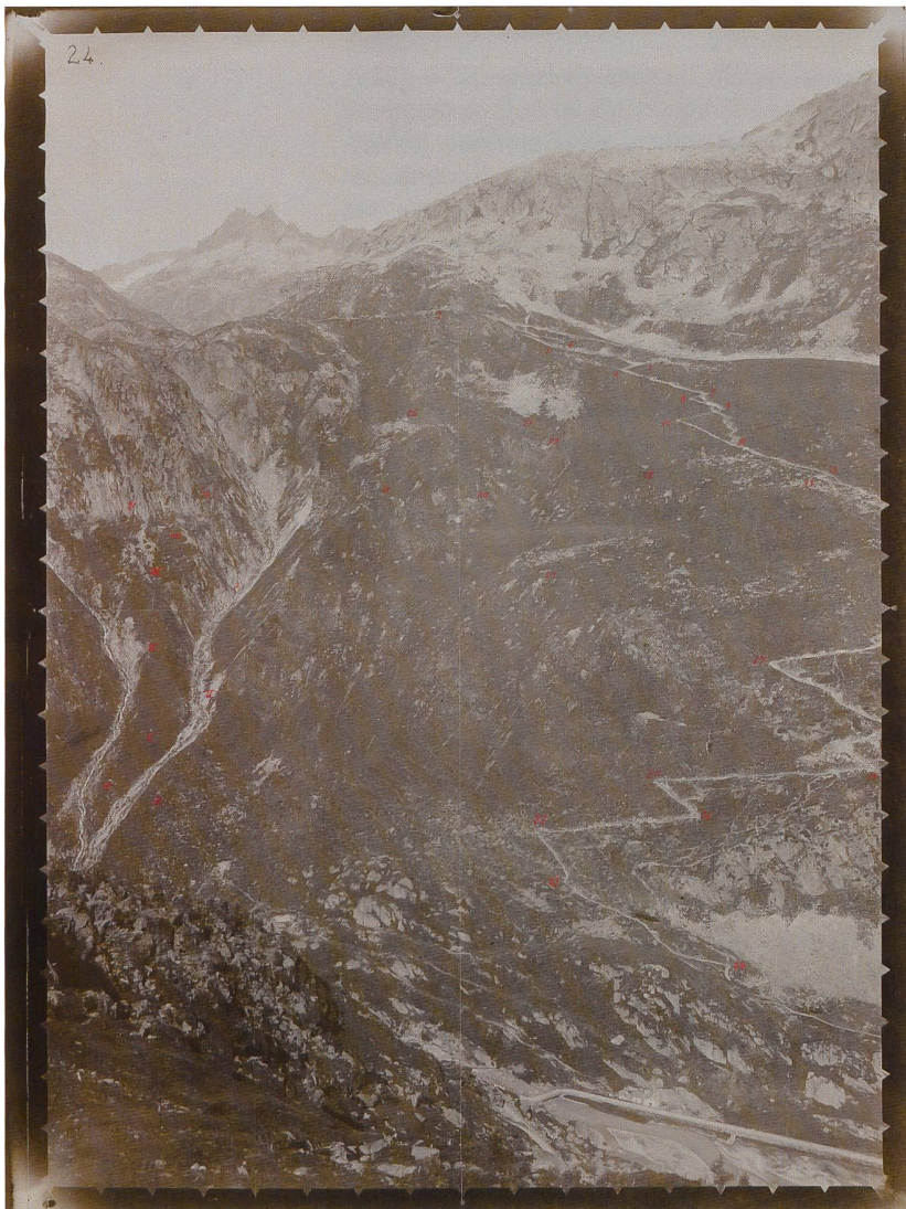
Abb. 26: Papierabzug von Glasplatte 33, aufgenommen mit dem Phototheodolit (vgl. Abb. 25) von Ingenieur Max Rosenmund im August/September 1892 vom Ostabhang der Schlucht Gletsch-Oberwald. Hinter der Senke im linken Bildteil liegt der Totensee am Grimselpass (BAR, E27/22056#40).
