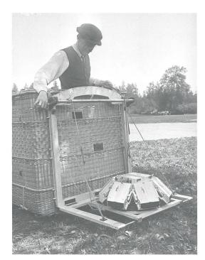
Abb. 29: Ingenieur Gustav Kammerer im Ballon, an dessen Aussenseite der «Photo-Perspektograph» hängt, ein Kamerasystem mit einer zentralen und sieben radial angeordneten Kameras, das polygonal begrenzte Abbildungen erzeugt (vgl. Abb. 31). Glasplattennegativ, 12 x 9 cm (swisstopo, Bildsammlung, Technische Aufnahme 1878).
