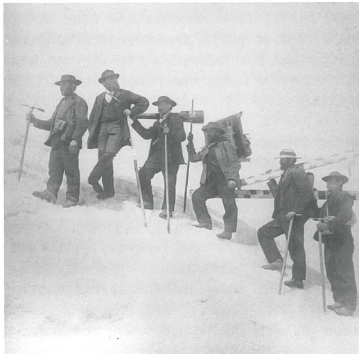
Abb. 18: Schwierige Aufgabe: Topographenequipe mit Ingenieur Gosset am Messtisch und Gehilfen mit Messlatte vor dem Spaltengewirr an der oberen Kante des Eissturzes des Rhonegletschers (swisstopo, Kartensammlung, LT K 37 1874, 6).
