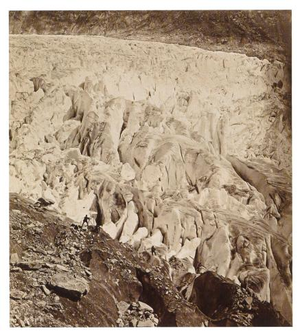
**Abb. 18:** Schwierige Aufgabe: Topographenequipe mit Ingenieur Gosset am Messtisch und Gehilfen mit Messlatte vor dem Spaltengewirr an der oberen Kante des Eissturzes des Rhonegletschers (swisstopo, Kartensammlung, IT K 37 1874. 6).
