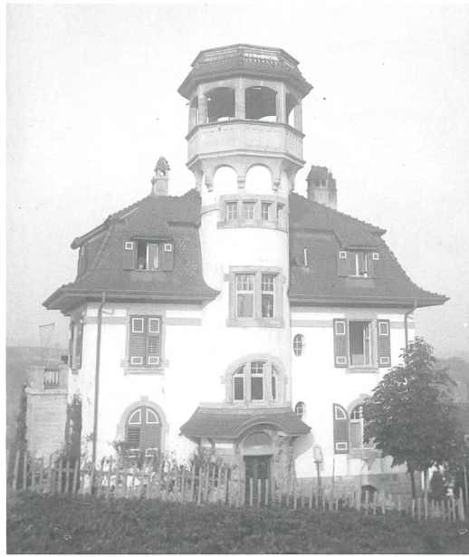
Abb. 61: «Villa Gockel» in Fribourg, 1911 von Physikprofessor Albert Gockel (1860–1927) erbaut. Auf der «oberen Plattform des Villaturms», wo auch ein Observatorium eingerichtet war, konnte bei den Triangulationsmessungen stationiert werden. An dieser Stelle steht heute ein Neubau, was diese technische Aufnahme zu einem historischen Baudokument macht. Undatiert. Glasplattennegativ 9x12 cm (swisstopo, Bildsammlung, technische Aufnahme 1016a, Inv. Nr. 000-390-634).
