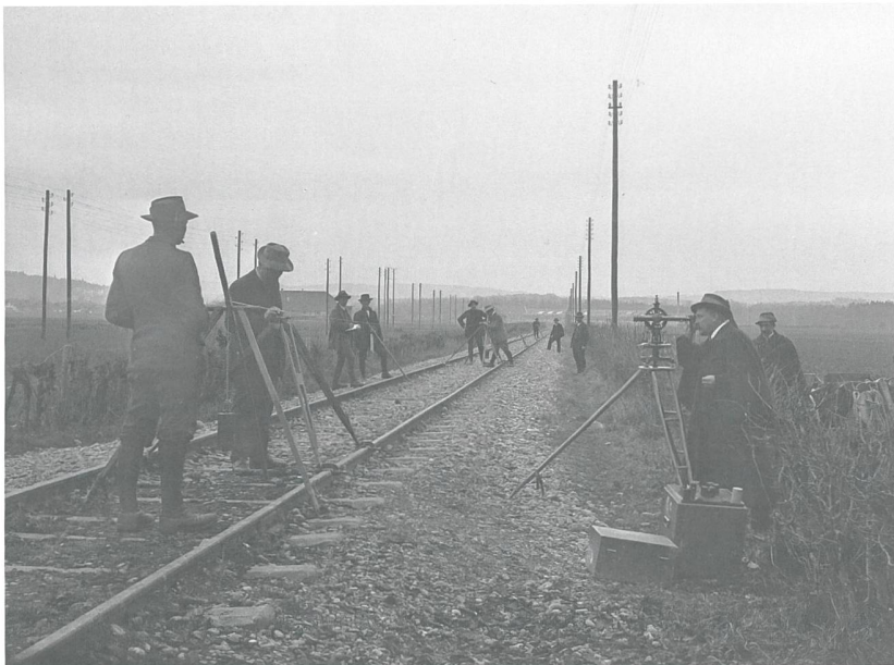
Abb. 65: Aufloten eines Fixpunktes bei der mit Invardrähten erfolgten Messung der 2.25 km langen Basis von Ostermündigen. Die Aufnahme von Johann Ganz entstand zwischen dem 16. und 19. Dezember 1913 im Gebiet Wankdorf (heutiges BERNEXPO-Gelände). Der als Basis dienende eingleisige Eisenbahnabschnitt war 1912 ausser Betrieb genommen worden. Das Bild zeigt, wie aufwändig damals die Messung einer längeren Distanz war. Glasplattennegativ 12x9 cm (swisstopo, Bildsammlung, technische Aufnahme 2280, Inv. Nr. 000-392-734).
