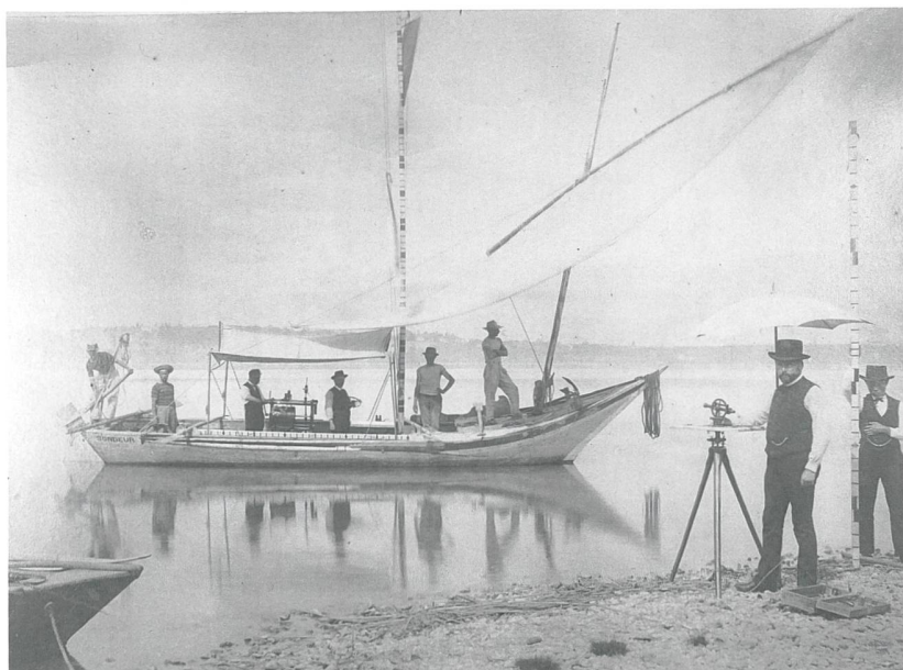
Abb. 66: Die Kartierung des Unbekannten: Schiff «Sondeur» 1888/89 auf dem Genfersee mit dem Seetiefenlotungsapparat der L+T, der von Ingenieur Jakob Hörnlimann (1846–1933) bedient wird. Paul Etier (1863–1919), der von 1902 bis 1919 als Waadtländer Staatsrat wirkte, vermisst als junger Topograph mit dem Messtisch vom Ufer aus die Position des Schiffes im Moment der Sondierung. Glasplattennegativ 12x9 cm (swisstopo, Bildsammlung, technische Aufnahme 1063, Inv. Nr. 000-390-718).
