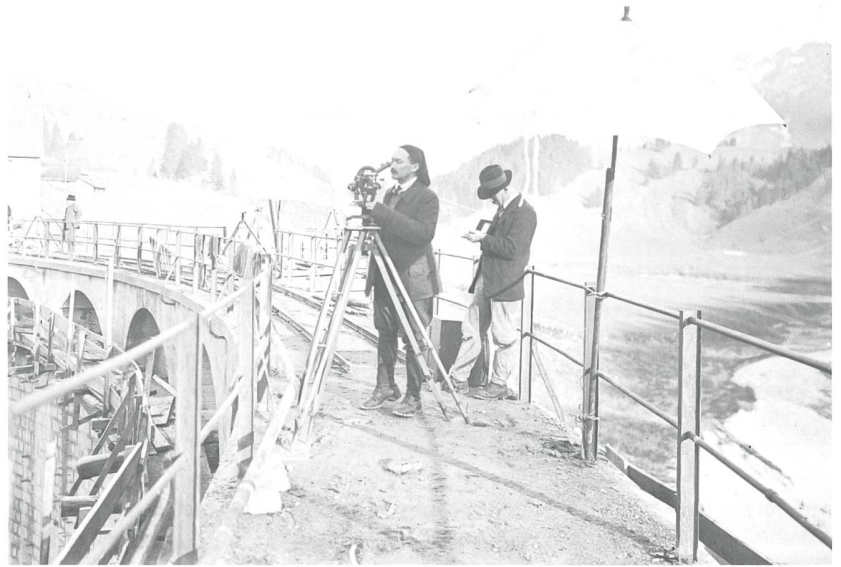
Abb. 67: Deformationsmessung mittels Theodolit an der Staumauer des Lac de Montsalvan durch Ingenieur Maurice de Raemy (1890–1969), den späteren Chef des TD.I und Vizedirektor der L+T. Aufnahme von 1924 durch Ingenieur Werner Lang, der damals die Methoden der Deformationsmessungen an Staumauern entwickelte und publizierte. Glasplattennegativ 12x9 cm (swisstopo, Bildsammlung, technische Aufnahme 2280, Inv. Nr. 000-392-726).
