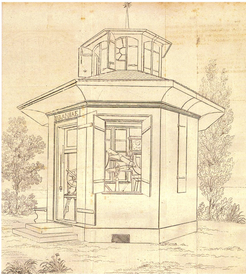
Abb. 15: Als Ursprung der Triangulation primordiale diente das behelfsmässige Observatorium in Form einer hölzernen Baracke, die 1812 von den französischen Ingenieur-Geographen zusammen mit Johann Friedrich Trechsel auf der Bastion Hohliebi der Grossen Schanze in Bern erbaut worden war. Lithographie von Burgdorffer (Universitätsbibliothek Bern).
