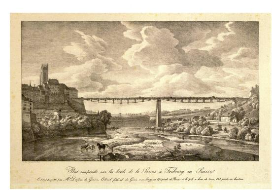
Abb.7: Pont suspendu sur les bords de la Sarine à Fribourg en Suisse. Ce pont projetté par Mr. Dufour de Genève, Colonel fédéral du Génie a un longueur 840 pieds de Berne et la pile a hors de terre, 154 pieds en hauteur. Diese 1825 von Dufour projektierte Hängebrücke, eine auf Metallkabel abgestützte Holzkonstruktion, erschien den Freiburgern zu wenig elegant und wurde nicht realisiert. Lithographie von Philippe de Fegely, Format: 49 x 32,5 cm (Musée d'art et d'histoire Fribourg, 10558 001).
