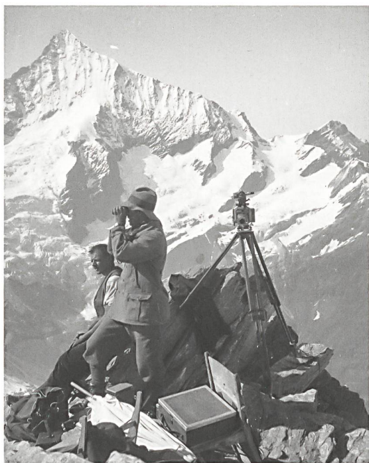
Abb.35: Terrestrische Aufnahme mit dem Phototheodolit Wild (Abb. 38) auf der Station Plattenhorn im Jahre 1930, im Hintergrund das Weisshorn (swisstopo, Bildsammlung, Technische Aufnahme 4506).
