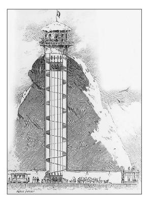
Abb.6: Wurde wegen Finanzknappheit nicht ausgeführt: das letzte Teilstück der Bahnprojektes Guyer-Zeller vom Jungfraujoch bis unter den Gipfel, der durch einen Lift und einer Wendeltreppe erschlossen worden wäre (Archiv Jungfraubahnen).
