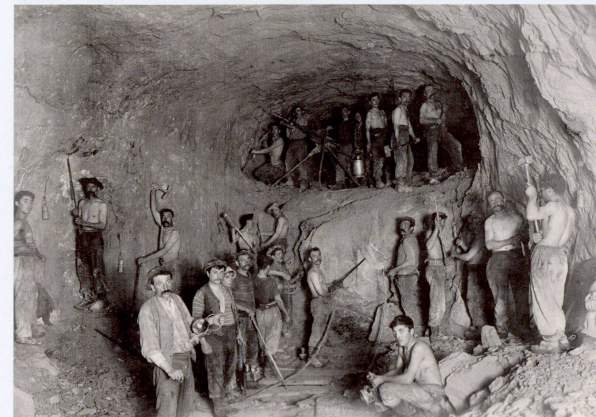
Abb. 2: Trotz moderner Bohrmaschinen wurde beim Bau des Simplontunnels immer noch viel von Hand herausgebrochen. Aufnahme aus dem Tunnelinneren der Nordseite.
