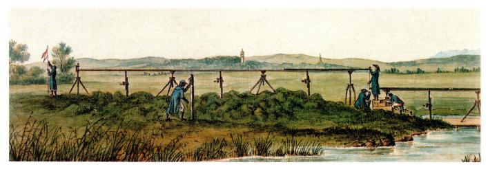
Abb. 17: Etwa so dürfte die Basismessung von 1834 im Grossen Moos ausgesehen haben. Ausschnitt aus einem Aquarell von F. de Daumiller (1799–1879), welches die Messung der Basislinie zwischen Oberföhring und Aufkirchen in Bayern zeigt. (In: Seeberger (2001), S. 18/19)
