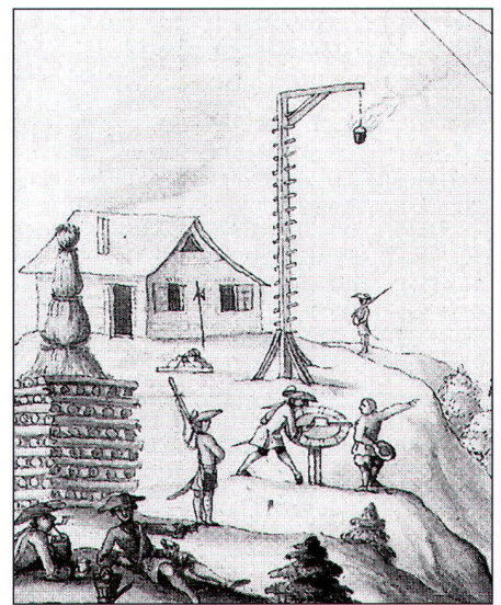
Abb. 11: Ausrüstung einer Hochwacht: Rechts auf einem Pflock die Scheibe mit den Visierlinien und dem drehbaren «Absichtsdünnchel» zur genauen Lokalisierung des Feuers. Ausschnitt aus dem Hochwachtenplan; ganz abgebildet in: Cartographica Helvetica 13 (1996), S. 24 (Zürich, Handschriften-Sammlung Zentralbibliothek).
