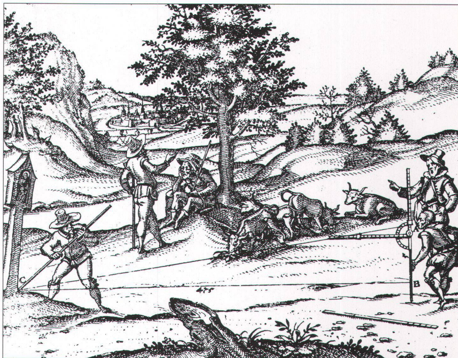
Abb. 4: Indirekte Streckenmessung. Aus: Novum Instrumentum Geometricum von Leonhard Zubler, Basel 1625.
