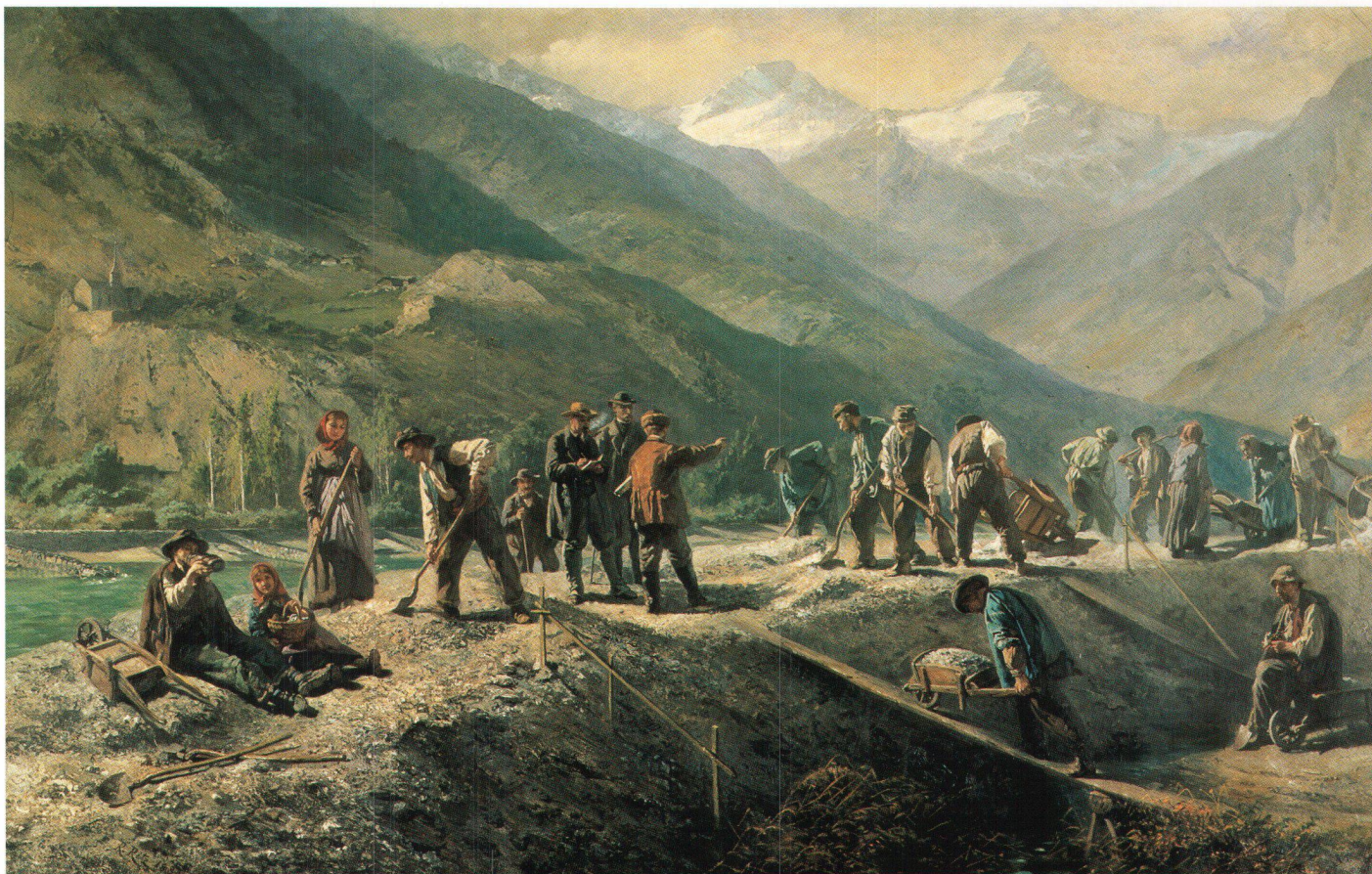
Abb. 3: Darstellung der Bauarbeiten am Linthkanal (Archiv «Linth-Escher-Gesellschaft»).
