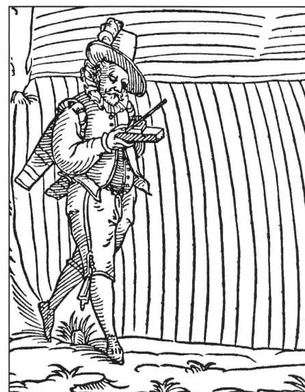
Abb. 3: Feldmesser bei der Arbeit im Gelände. Er verwendet dabei einen Kompass mit einer Zielvorrichtung zur Richtungsbestimmung. Die Distanz ermittelt er durch das Schrittmass. Holzschnitt aus Paul Pfinzing: Methodus Geometrica , Nürnberg 1598.
