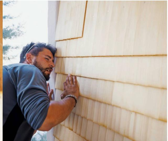
Les tavillons sont-ils bien alignés? Tristan Ropraz examine la surface qu'il vient de recouvrir et qui résistera désormais au vent et aux intempéries durant 35 à 40 ans.
