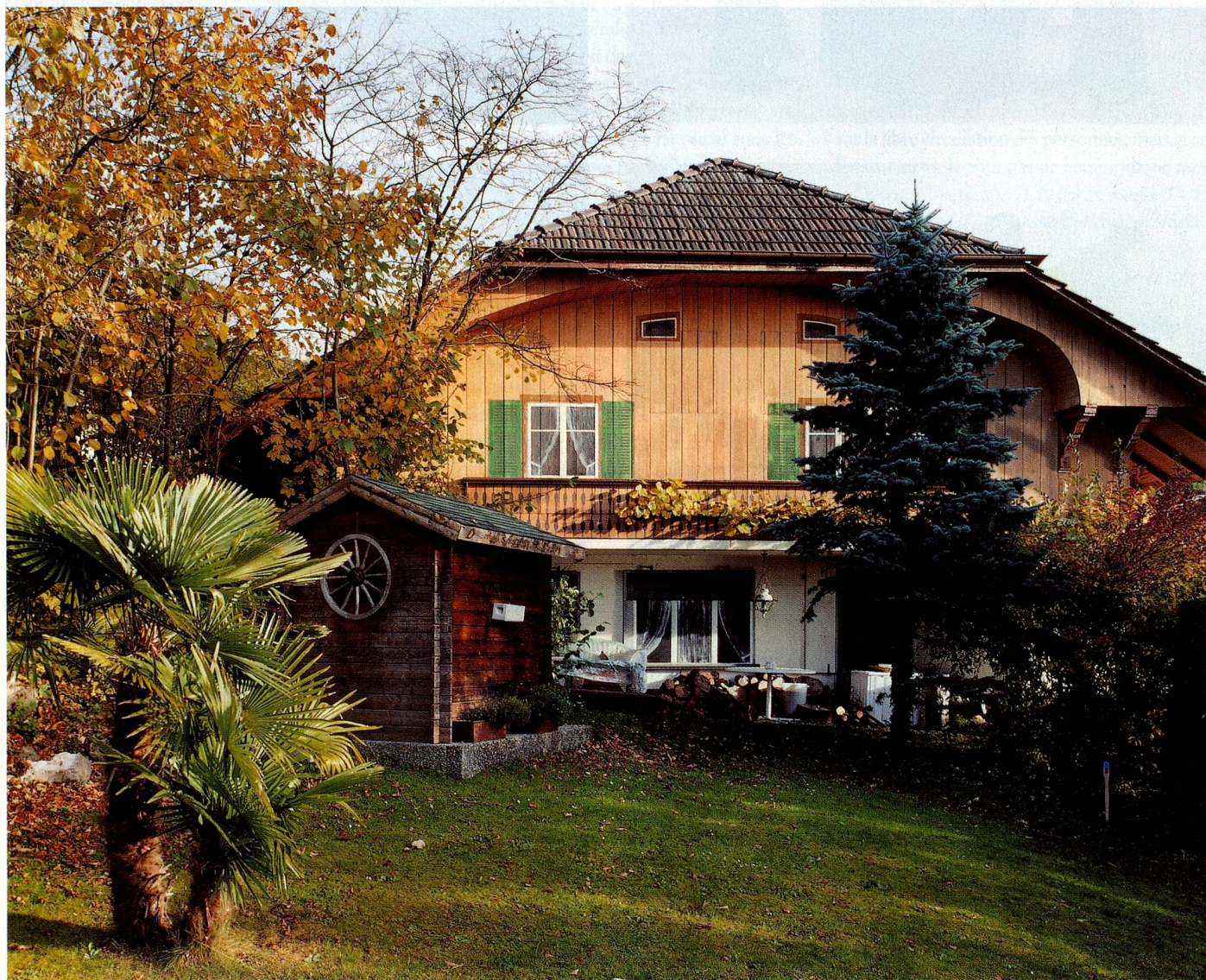
Chalet, 1941, fortin d'infanterie, Hilterfingen (BE): construction en béton avec toit de tuiles et auvent cintré. Fenêtres, volets et balustrade du balcon peints sur le revêtement de planches. La main-courante du balcon est en saillie et la balustrade plantée d'une vigne sauvage. Sous le saillant se trouve l'entrée, déguisée en fenêtre au store à demi relevé.
