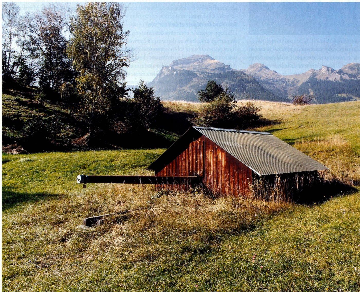
Cabane, 1939-43, tourelle blindée de la forteresse Magletsch à Oberschan (SG): la tourelle est dissimulée derrière un coffrage de planches et coiffée d'un toit en tôle ondulée. Le fût du canon n'est pas masqué, mais fermé d'un couvercle.
