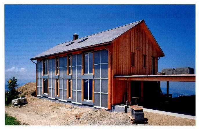
Projet-pilote dans le canton d'Appenzell: les murs de la maison sont construits selon la nouvelle technique d'isolation thermique avec emmagasinage de l'énergie solaire. (Photo: Oerlikon Journalisten)
