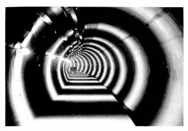
Pour l'accélérateur de particules LEP, on a construit un tunnel circulaire de 27 kilomètres de circonférence. Le tunnel a un diamètre de 3,8 mètres. (Photos: Cern)
