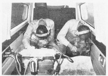
Chambre de prise de vues montée dans un avion
