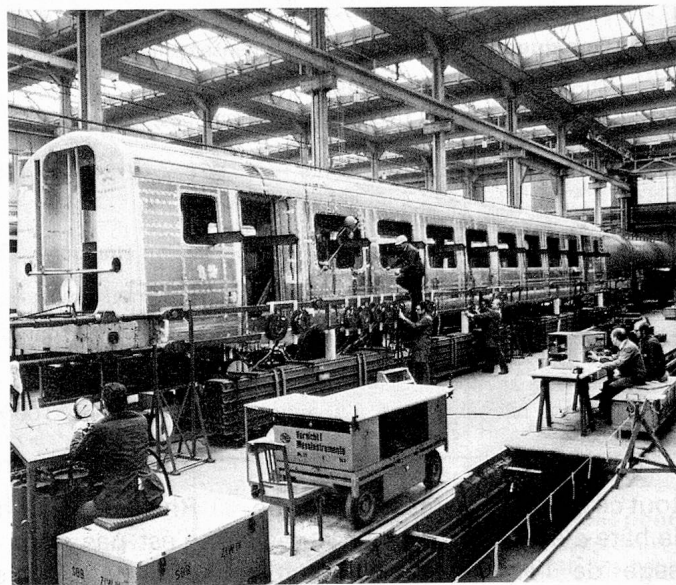
Construction d'un wagon CFF à Neuhausen (SIG).
