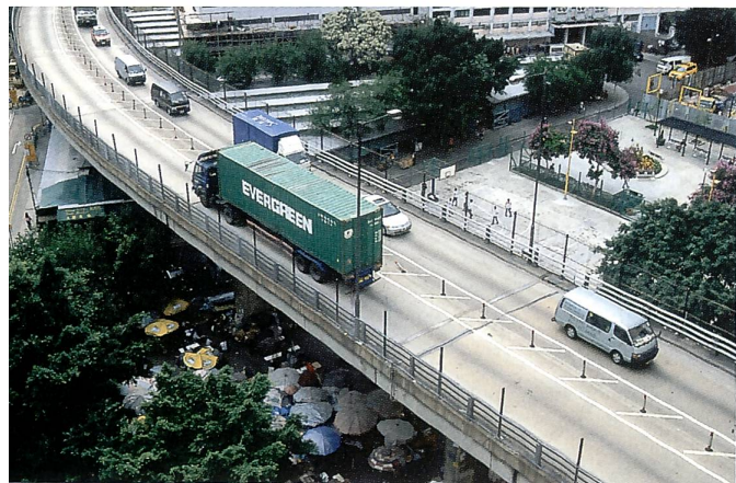
Hong Kong. Auslagerung eines Marktes unter die Substrukturen der Stadtautobahn. Venedig. Industrie im Archipel der Lagune Fotos: Karl Richter
