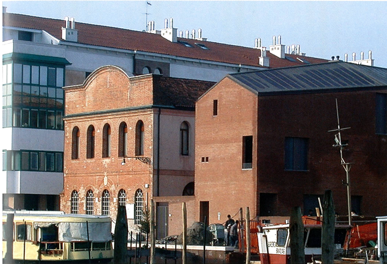
Venedig. La Giudecca – Konversion des ehemaligen Jungmans-Areals, neue Sozial- und Studentenwohnungen nach einem städtebaulichen Konzept von Cino Zucchi, Zucchi Architetti, Mailand (1997-2003) Fotos: Anja Schlamann
