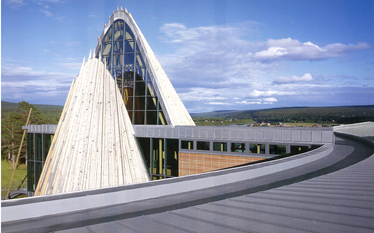
Parlamentsgebäude der Lappen/Samen, N-Karasiok, Architekt: Stein Halvorsen, Christian A. Sundby
