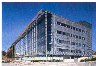
Digbeth Millennium Point, Birmingham, Großbritannien; Winkelstehfalz und Kassetten mit Sonderprofil
