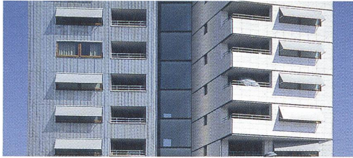
Detail der Fassade. Rückenansicht. Kontrast zum Résidence-Riegel von Aurelio Galfetti
