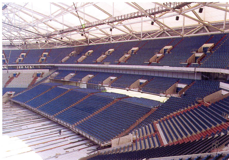
Ober- und Unterrang von Donges gebauten Südtribüne in der „Arena AufSchalke“. Unterrang mit abgeklappten Sitzreihen. Rasenspielfeld herausgefahren. Fotos: Donges Stahlbau GmbH
