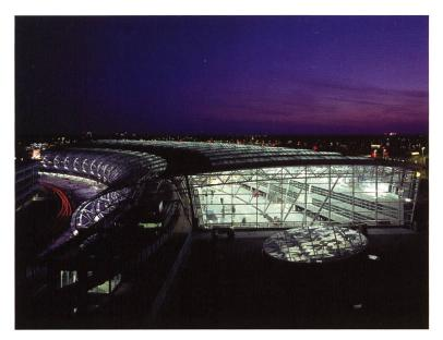
Für die Außenbeleuchtung fordert die gewölbte Fassade ein individuelles Beleuchtungskonzept. Zwei direkt strahlende und ein indirekt strahlender Werfer sind so positioniert, dass sich das Licht auf den Rohrprofilen und der durchlässigen Fassadenstruktur bricht und reflektiert. Beleuchtungssysteme wurden so in die Stahlkonstruktion integriert, dass sie gleichsam aus sich selbst heraus leuchtet. Am Abend und in der Nacht wirkt die Fassade als große Lichtgeste.
