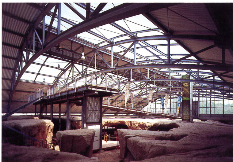
Träger von Donges bilden das stützenfreie Gerüst der Hightech-Überdachung aus Aluminium-Wellblech, Glas und transparenten Luftkissenbändern. Fotos: Donges Stahlbau GmbH
