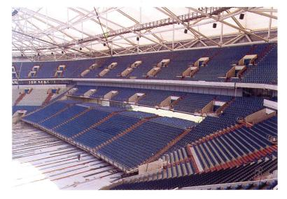
Ober- und Unterrang von Donges gebauten Südtribüne in der "Arena AufSchalke". Untergang mit abgeklappten Sitzreihen. Rasenspielfeld herausgefahren. Fotos: Donges Stahlbau GmbH
