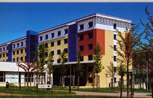
Bunt und lebendig - Plattenbausanie rung in drei ArGeTon®-Farben: Saharagelb, Sandfarben und Naturrot: Technologie-Zentrum-Vorpommern (TZV) in Greifswald
