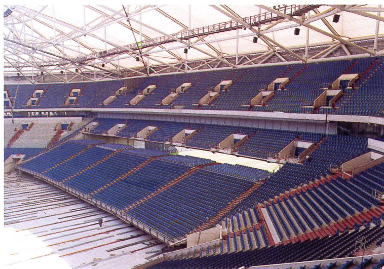
Ober- und Unterrang von Donges gebaute Südtribüne in der „Arena AufSchalke“. Unterrang mit abgeklappten Sitzreihen. Rasenspielfeld herausgefahren. Fotos: Donges Stahlbau GmbH
