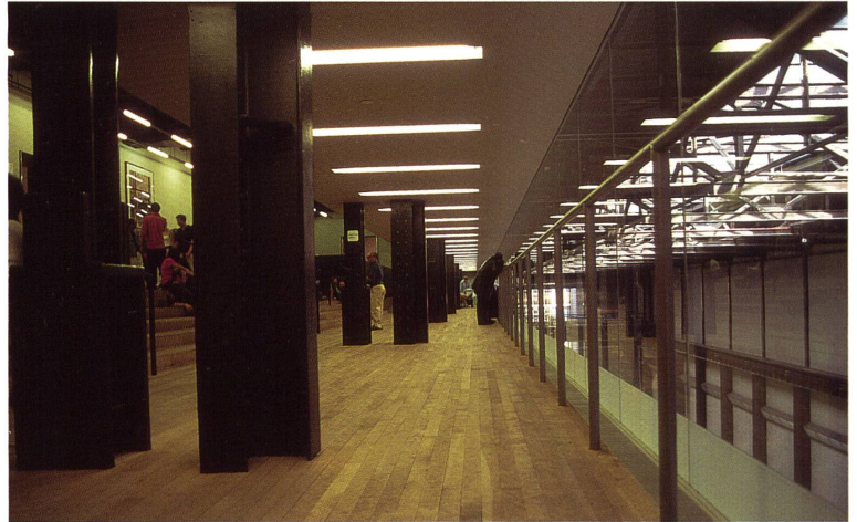
Tate Modern. Delikat belichtete Wandelgalerien mit Ausblick auf den großen Raum der ehemaligen Turbinenhalle des Kraftwerks. Die neuen Räume schließen mit eigenem Stahltragwerk an die Stützenstellung der Turbinenhalle an. Blick über die Bay windows
