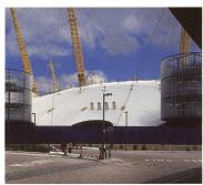
Die Membran selbst besteht aus teflonbeschichtetem Glasfibergewebe. Ein ringförmiger Betonbalken auf 8.000 Pfählen bildet das Fundament der Peripherie
