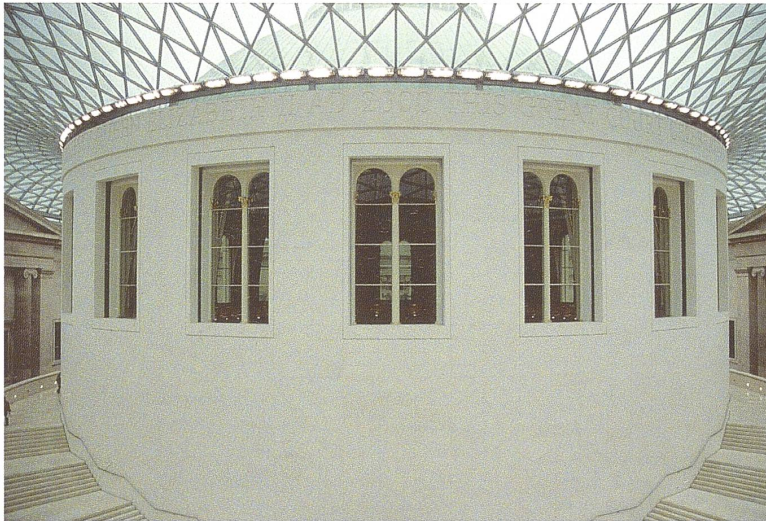
Great Court. Rotunde des Reading Room mit neuer Wandverkleidung zum Court und dem auf der „Snow gallery“ ansetzenden Glasdach, dem „Dachgeflecht“ der 3312 Felder Architekten: Foster and Partners, London Structural engineering: Buro Happold Engineering, London Lichtdesign, Claude R. Engle
