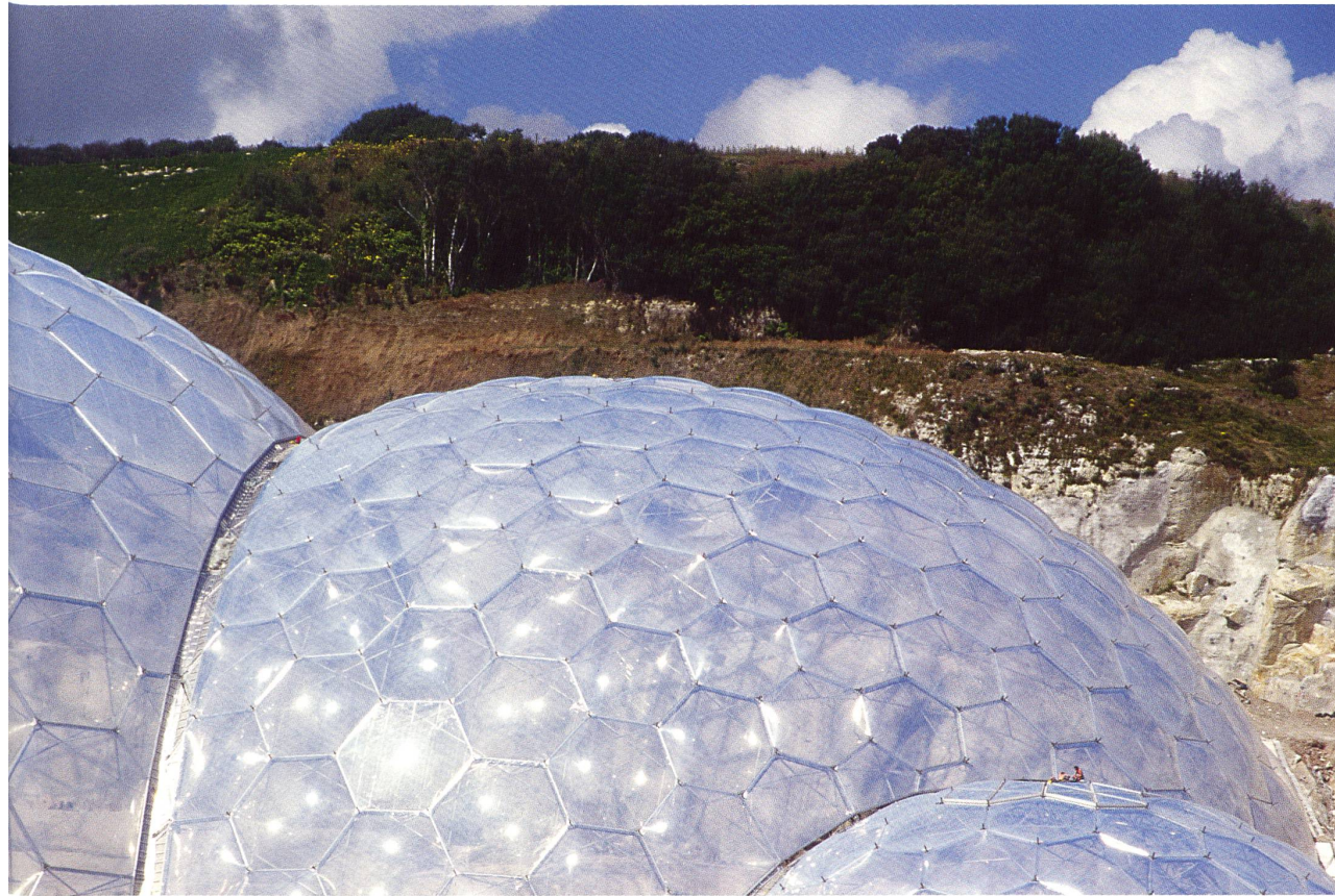
Detail der Dachlandschaft. Eingespannte Folienkissen (EFTE)
