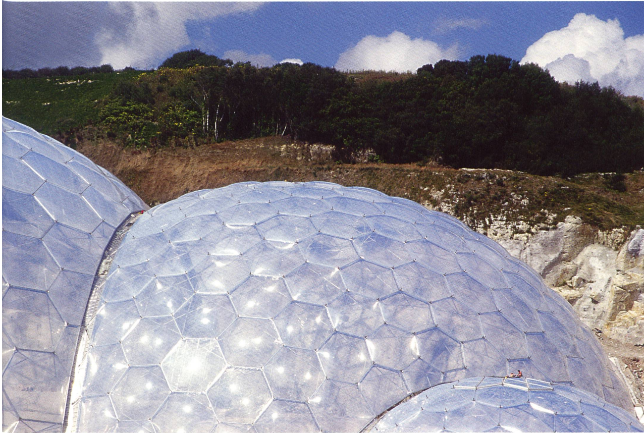
Detail der Dachlandschaft. Eingespannte Folienkissen (EFTE)
