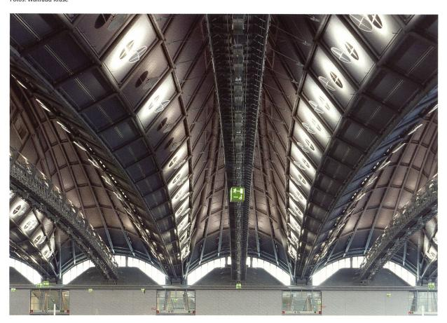
an den Entwurf des unregelmäßig verformten Gitters. Jedes einzelne Glaselement unterscheidet sich vom anderen. Man kann sich fragen, ob der Aufwand noch sinnvoll ist, technisch gesehen sind die Freiheitsgrade kein Problem.
