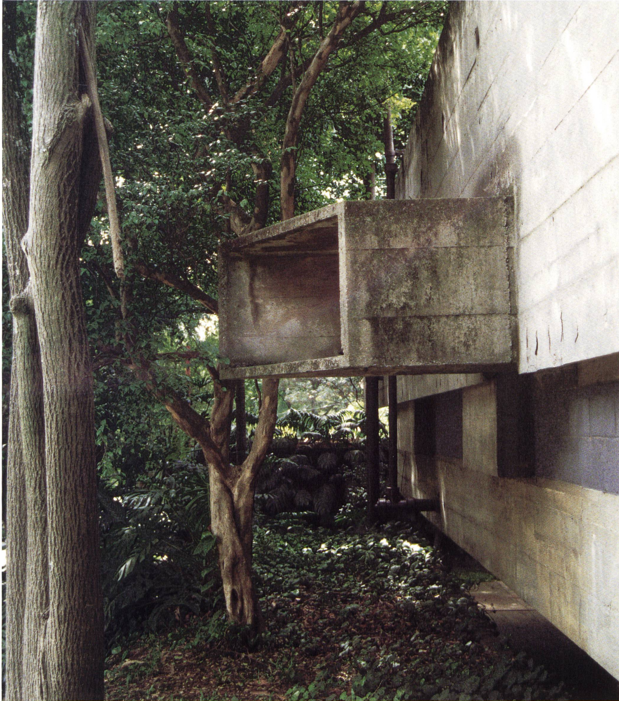
Paulo Mendes da Rocha Casa no Butantã, São Paulo (1960) Fenster zur Arbeitszone im Wohnraum Foto: Annette Spiro, Zürich
