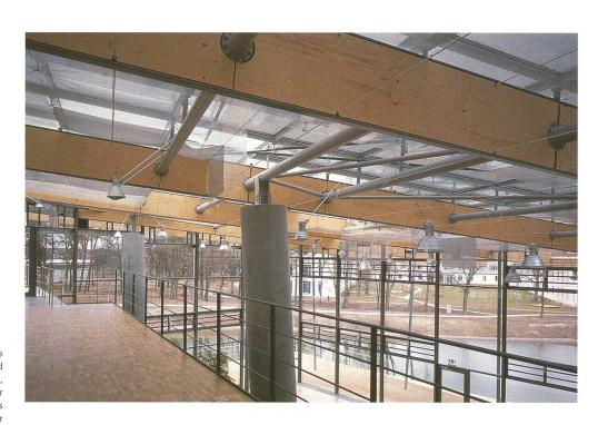
Tragwerk aus Haupt- und Nebenträgern, innenliegender Sonnenschutz aus semitransparenter Polycarbonatfolie Fotos: Roland Halbe
