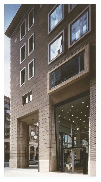
Die ursprüngliche Position der oben nach innen geneigten Schaufenster bezeugt das Stützenprofil
