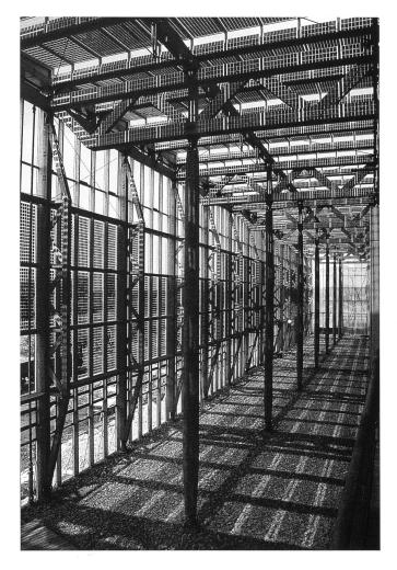
Perspektive des Hallenraumes, Schattenbildung der Photovoltaikflächen des Solarkraftwerks, in das das ca. 12 600 m<sup>2</sup> große Glasdach des Hallenraumes integriert ist
