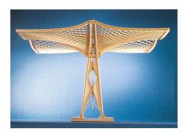
EXPODACH, Flächen aus doppelt gekrümmten Gitterschalen, zentrale Tragstruktur aus Holzstämmen, Modul eines Feldes
