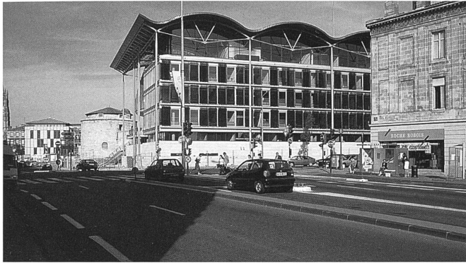
Perspektive vom Cours d'Albret stadteinwärts: Neuer Flügel des Justizpalastes, Wehrturm des Fort du Hâ, Kopfbau der Schule der Magistratur (Rogers kontextualistisch), Kathedrale Saint-André
