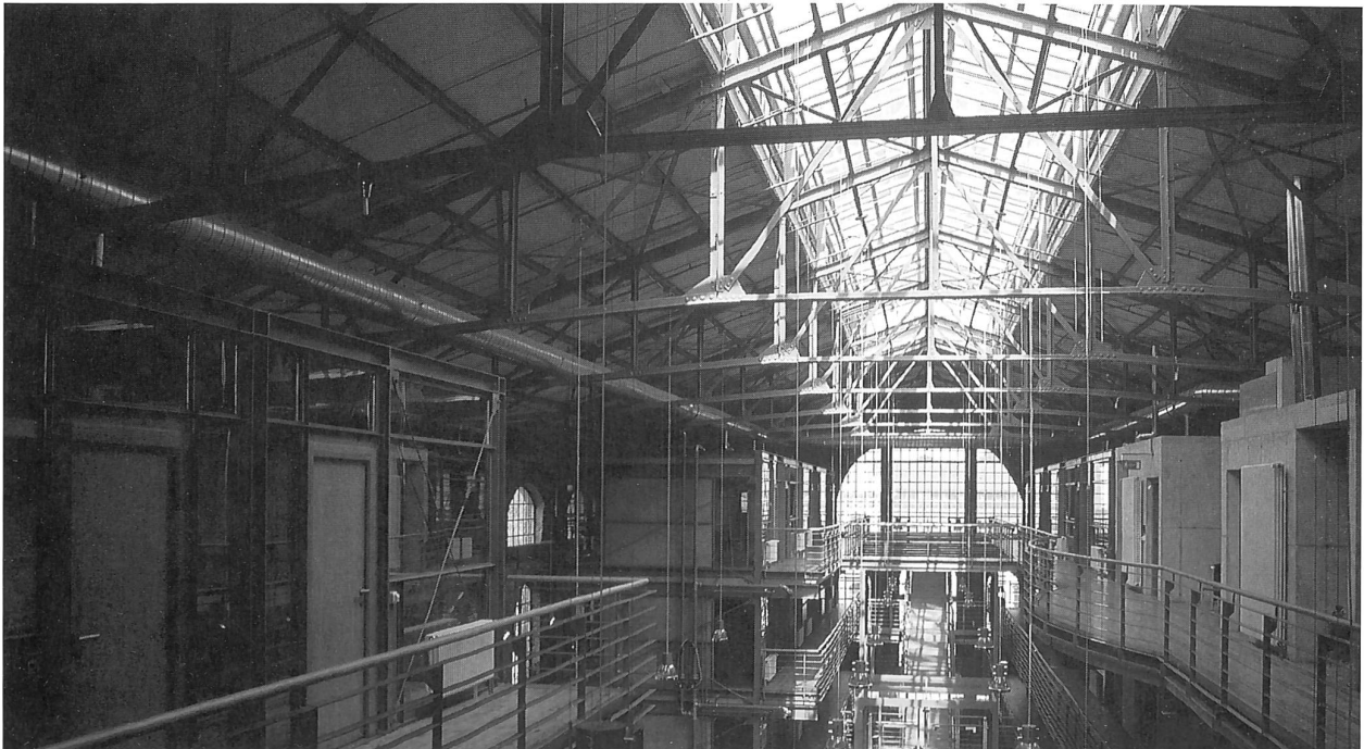
Umbau von Maschinenhalle und Fördermaschinenhalle der ehemaligen Zeche Brockenscheidt, Waltrop Architekt: Klaus-Dieter Luckmann, Coesfeld
