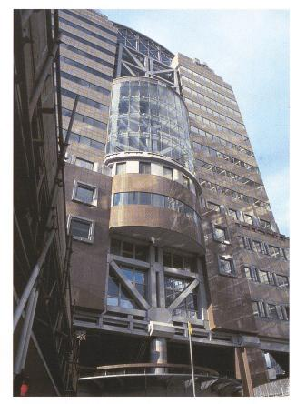
Die programmatische Idee der Projekte und ihre konstruktive Herausforderung entstanden aus dem unternehmerischen "Erfordernis", die jeweils vorhandenen Verkehrsinfrastrukturen zu überspannen, um den Luftraum überbauen und die enormen Windkräfte durch riesige Stahlkonstruktionen über der reduzierten Basis auffangen zu können. Gerade diese bahn- und straßenüberspannenden Torbauten sollten die neo-liberalistischen "Tugenden" Solidität und Finanzstärke demonstrieren.
