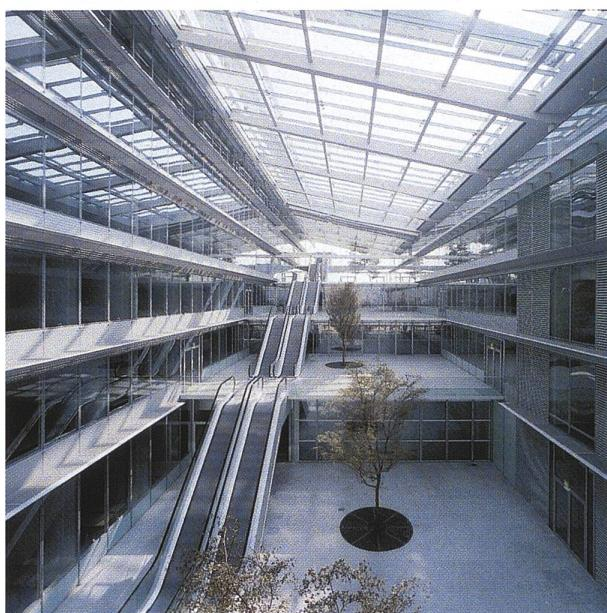
3,50 m große Verbundsicherheitsverglasungen bilden den Raumabschluß und sorgen für behagliche Arbeitsplätze. Zum Grundstücksinnenbereich und zum Atrium sind die großen Fensterelemente per Knopfdruck elektromechanisch zu öffnen und sorgen für eine natürliche Be- und Entlüftung der Arbeitsplätze.
