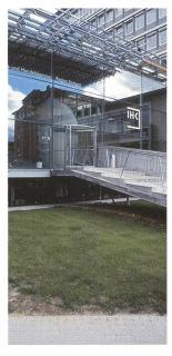
Diese Konstruktion soll gleich mehrere Funktionen übernehmen. Durch eine stehende Luftschicht zwischen den beiden Schalen wird der Dämmstandard des Bauteils erhöht – ohne dabei an Transparenz zu verlieren. Die Strahlungsverluste gegen die äußere Glasscheibe werden durch eine IR-reflektierende Beschichtung der inneren Lamellen reduziert. Die Lamellen funktionieren dabei als Tageslichtlenkung ebenso wie als Verschattungselemente und dienen insgesamt dazu, die solaren Gewinne zu kontrollieren.
