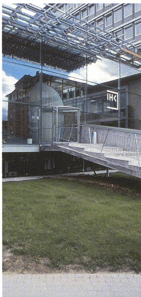
Schwebende Fächer, schwebende Decks Foto: Reinhart Wustlich
